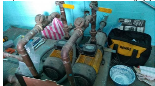
Fig 10. Conexión a los motores trifásicos.
