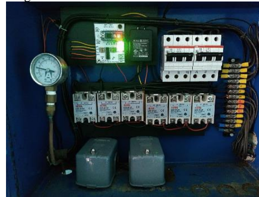
Fig. 9 Módulo de control-sensado y de potencia instalados.
